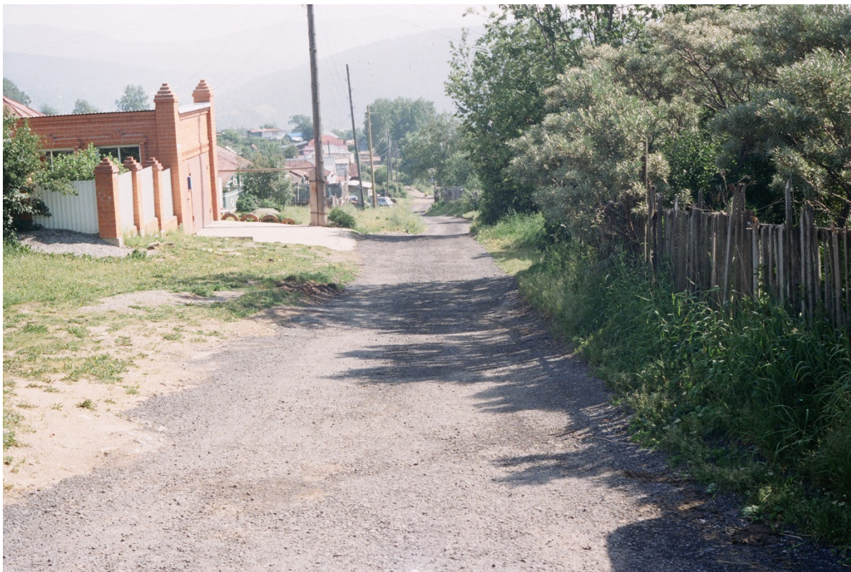
Дорога после отсыпки в КТОС «Уреньгинский»
