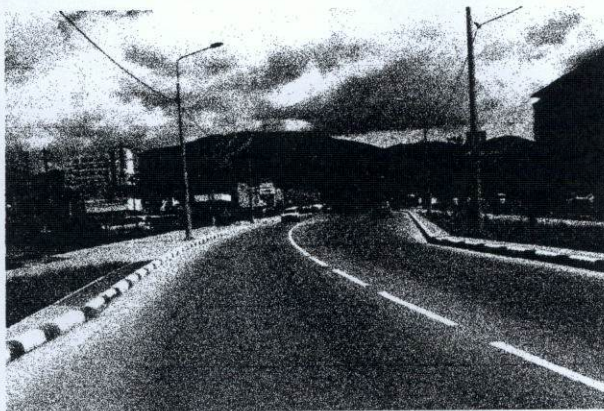
Реконструкция дорожного покрытия
